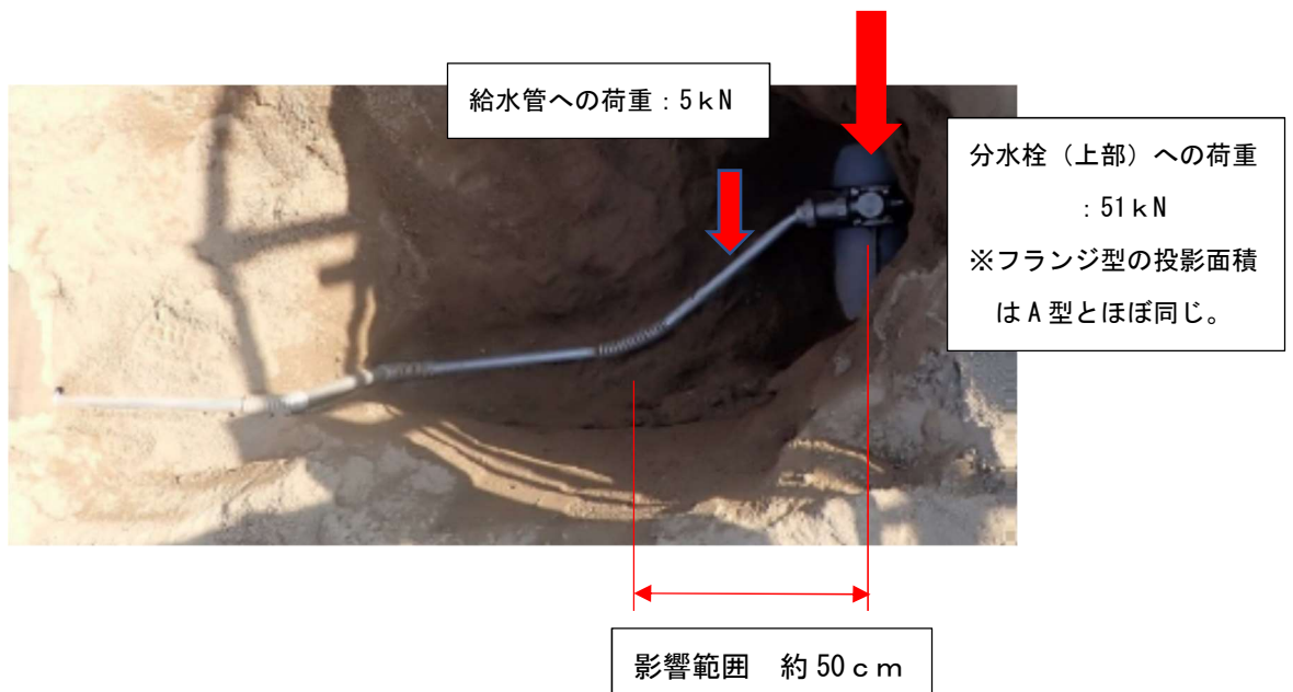
図 8-6 耐震試験後の給水配管の状況と荷重値 (SUS 波状管)
