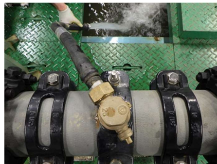
図 7-36 耐震試験後の供試品 2
