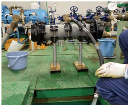
図 7-35 耐震試験後の供試品 1
