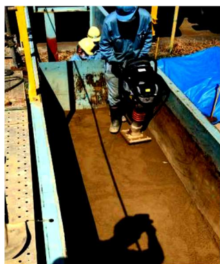
図 6-4 締め固め
