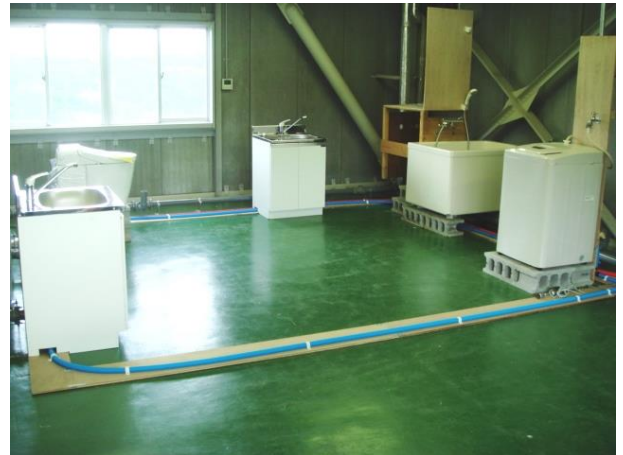
写真12 戸内モデル配管（全体）
