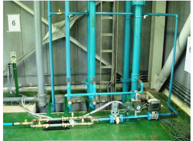
写真10 横取出し管周り
