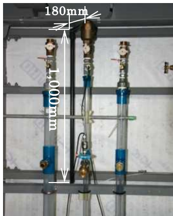
立管頂部：25 吸排気弁
