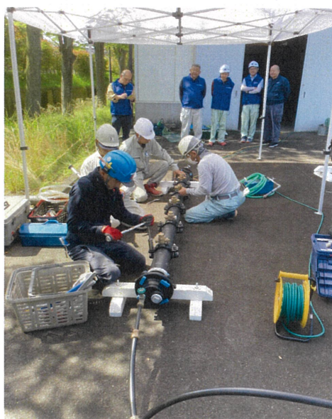
写真3 実技作業状況1
