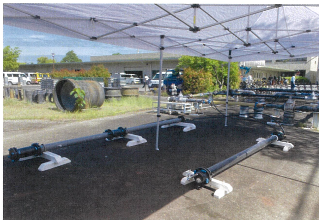
写真1 実技会場設営状況
