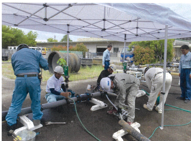
写真5 実技作業状況3
