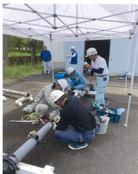
写真4 実技作業状況2
